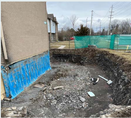
1. Les travaux d'excavation sont terminés et les fondations peuvent être coulées.
