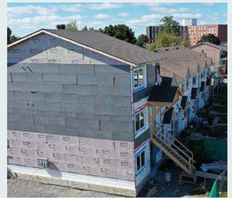
3. La charpente extérieure est terminée.
