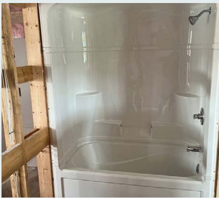
4. La charpente intérieure prend forme et des baignoires sont installées.
