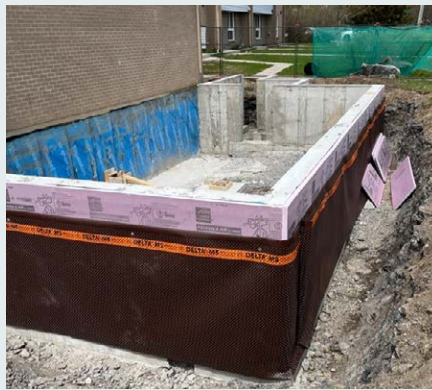
2. Les fondations sont terminées.
