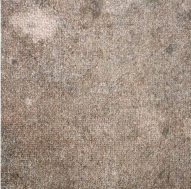
**La décoloration et les cernes sur le dessous de la couverture indiquent une infiltration d'eau**
