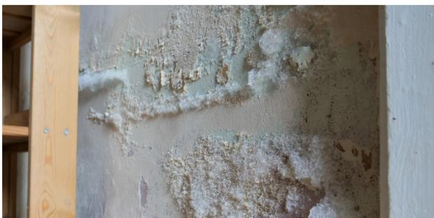
**Des taches d'eau sur les murs indiquent un problème d'humidité.**
