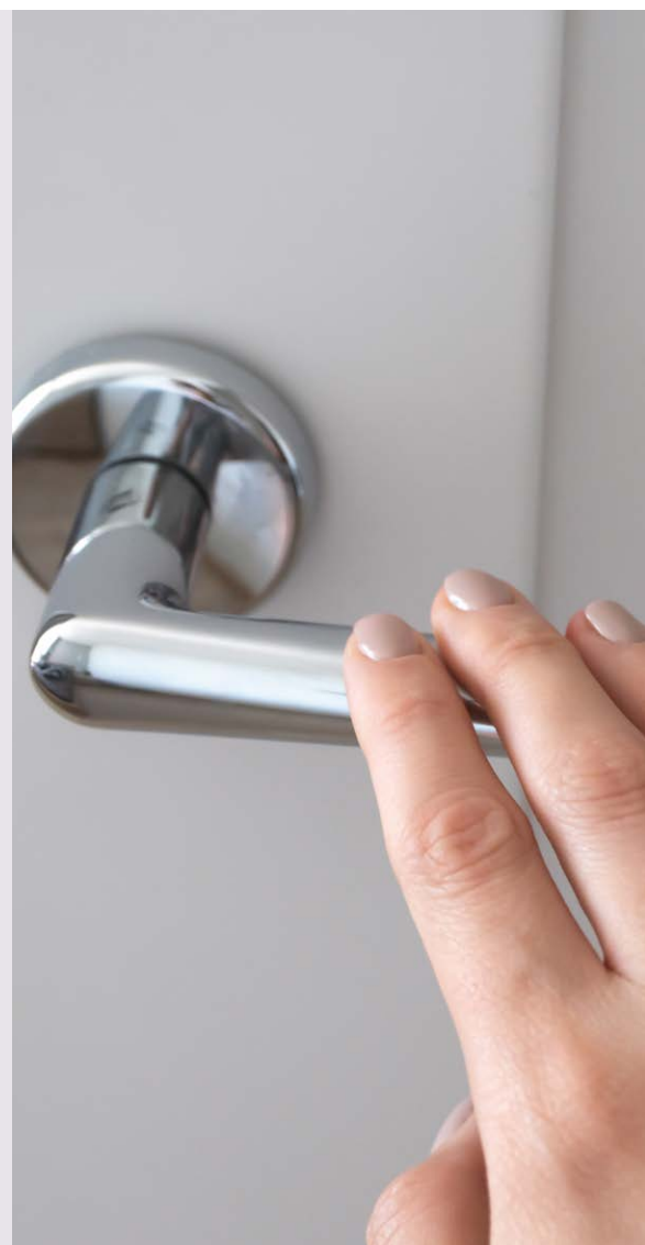
Figure 4 : Les poignées à levier permettent d'ouvrir une porte avec le coude ou le poing, ce qui est utile pour les personnes souffrant d'arthrite ou qui ont les mains pleines.
