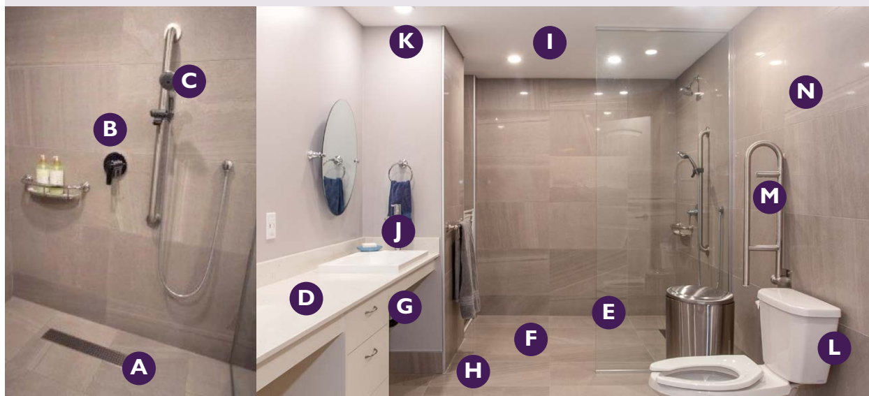
Figure 8 : Salle de bains avec douche à l'italienne, caractéristiques de la douche.
