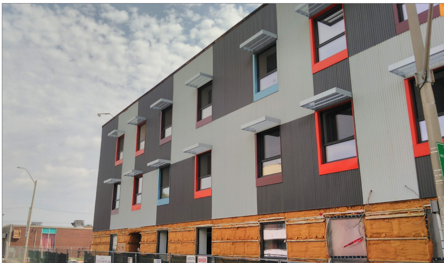
Figure 4 Photo extérieure de fenêtres à triple vitrage.
