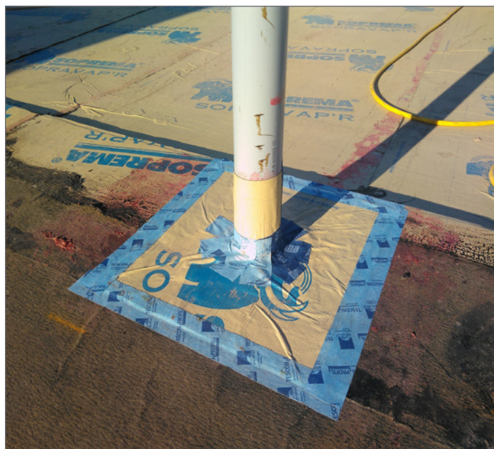
Figure 3 Étanchéité à l'air de la toiture : sortie de tuyau hermétique.
