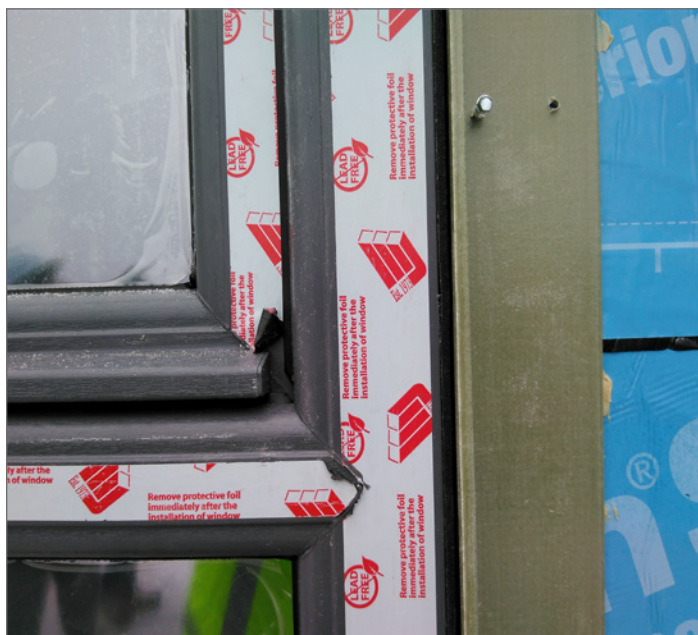
Figure 2 Détail d'une fenêtre étanche à l'air.
