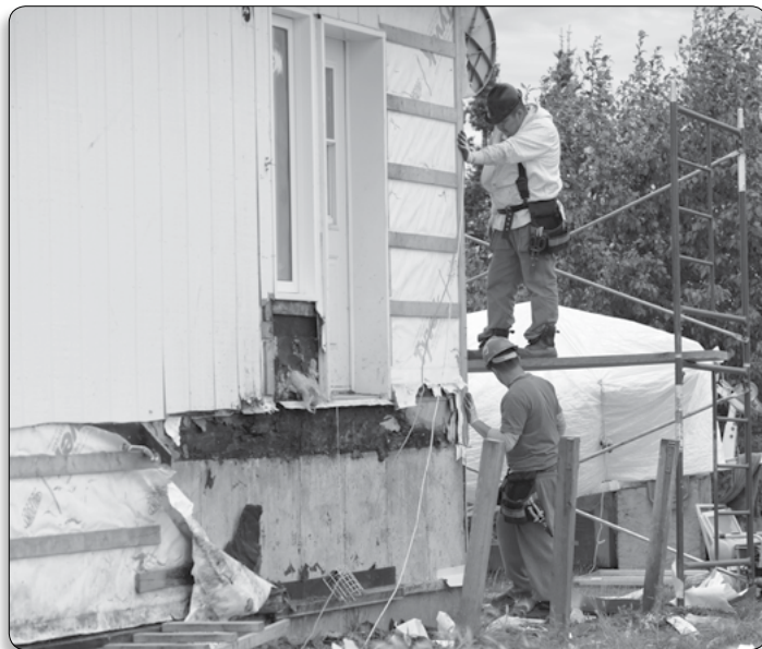
Entrepreneurs compétents réparant des dommages causés par l'eau
