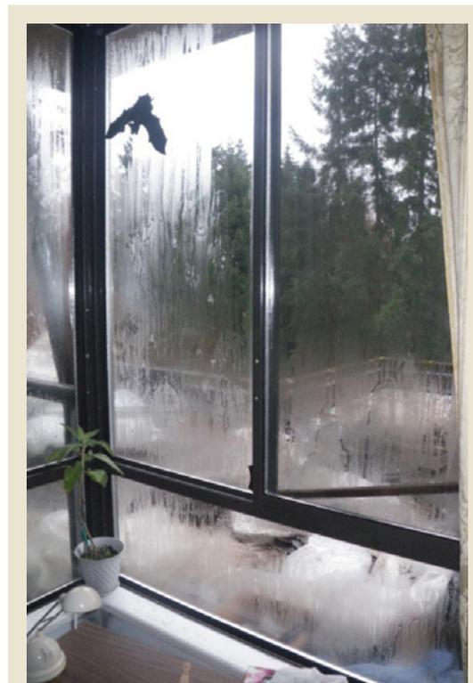
Figure 1.2 Condensation sur la surface intérieure des fenêtres.
