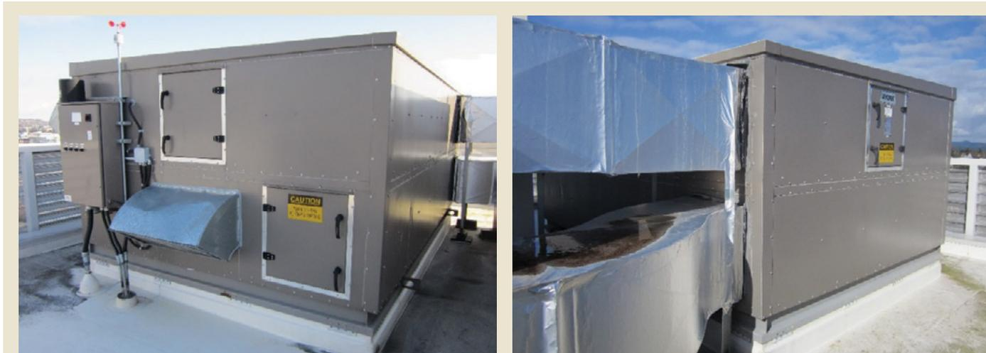
Figure 4.4 VRC central adapté à un immeuble collectif de 11 étages. L'appareil fournit une ventilation d'environ 6 000  $\text{m}^3/\text{min}$  à 90 logements.
