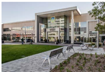
Vue sur la cour paysagée et les commerces Crédit photo : Kirkor Architects
