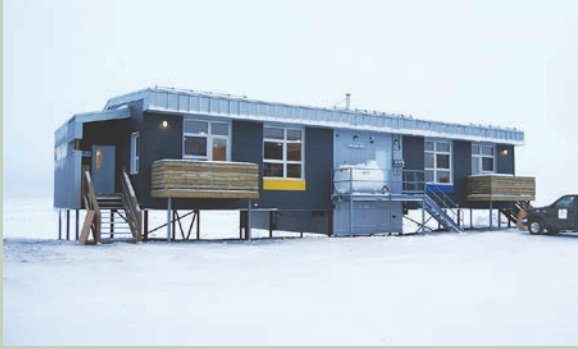
Prototype duplex exterior, photograph, H el ene Arsenault, SHQ.
