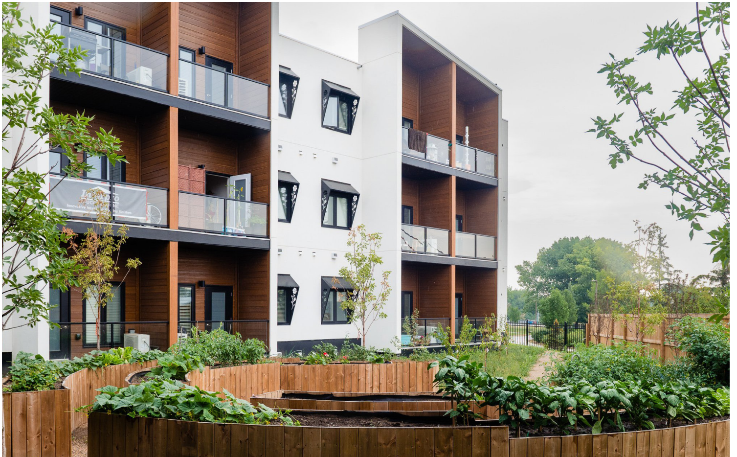
De haut en bas : Photo de la façade de l'immeuble, Jason Surkan et photo des jardins communs, Big Block Construction.
