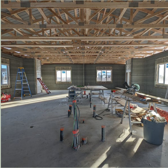
Photo d'une maison en béton imprimée en 3D avec l'ossature de toit installée, Siksika Nation Tribal Administration.
