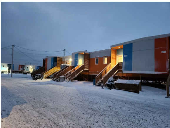
Photo d'un logement communautaire à Sanirajak, Bawating Building Science.
