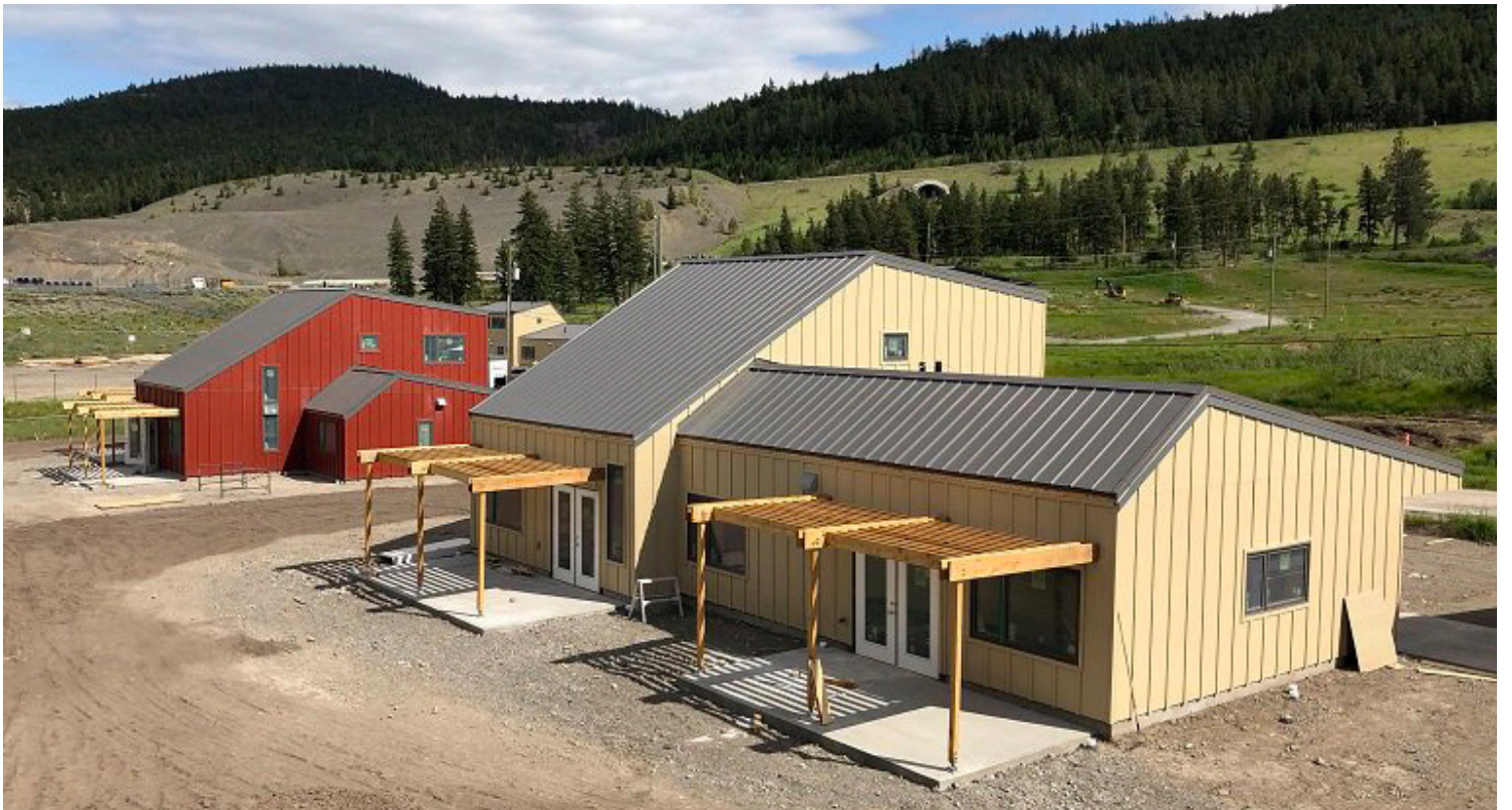
Photo de trois duplex achevés dans la communauté de la bande Cook's Ferry, Urban Arts Architecture.
