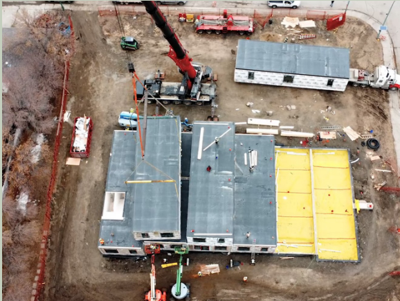
Photo des logements modulaires mis en place à l'aide d'une grue, Big Block Construction.
