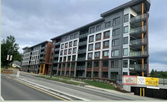
Photo de la façade de l'immeuble, Yellowridge Construction.
