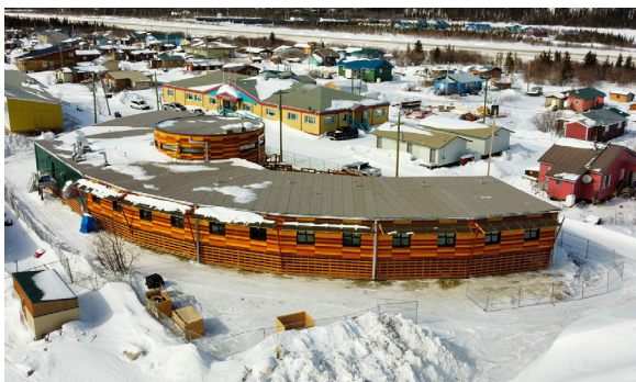
De haut en bas : Rendu de Déline Housing, Formline Architecture + Urbanism Inc. ; photo de la cérémonie d'ouverture de l'Aboriginal Children's Village Dave Pranteau, Colombie-Britannique; photo de la construction misatimosimôwin mihkowâp (Horse Dance Lodge), Big Block Construction et photo de la Victoria Blake Memorial Elders Home, Taylor Architecture Group.
