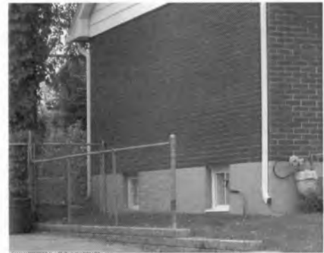
Descentes pluviales de la maison
