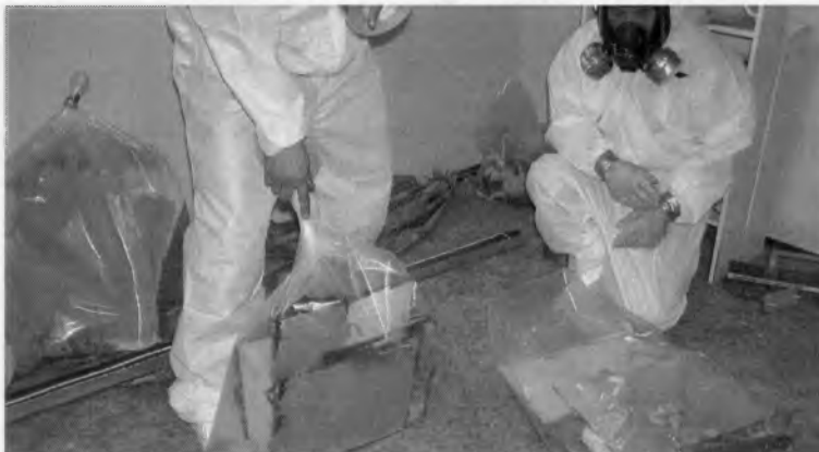
Entrepreneurs spécialisés ensachant les moisissures en vue de leur élimination
