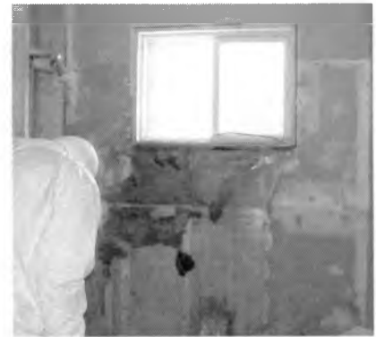
Des professionnels enlèvent l'isolant endommagé
