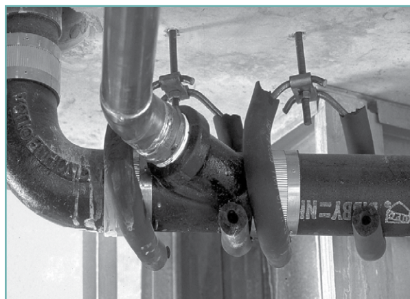
Figure 4-14 Points de pénétration de plomberie
