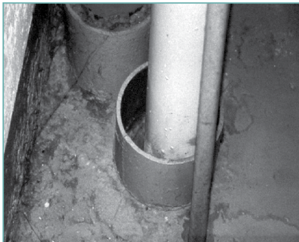
Figure 4-30 Pénétration type dans un plancher
